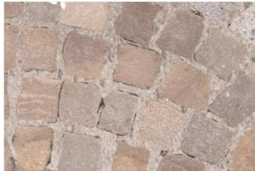
Abbildung 2: Natursteinpflaster in Beton
