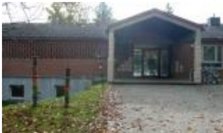
Außenstelle Anhausen, Gessertshäuser Str. 11
