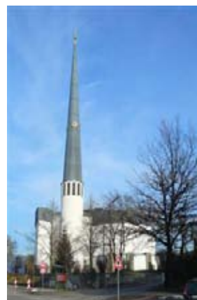
Neue Pfarrkirche D-7-72-130-3
